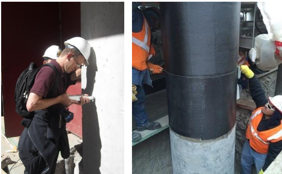
Figura 5.1.- Izquierda: Evaluación con esclerómetro durante los proyectos de reparación de edificios UdeC post-terremoto 27 febrero 2010 (Foto: Archivo M. Pradena) – Derecha: Reforzamiento de columna con fibra de carbono (DuBose, 2020).
